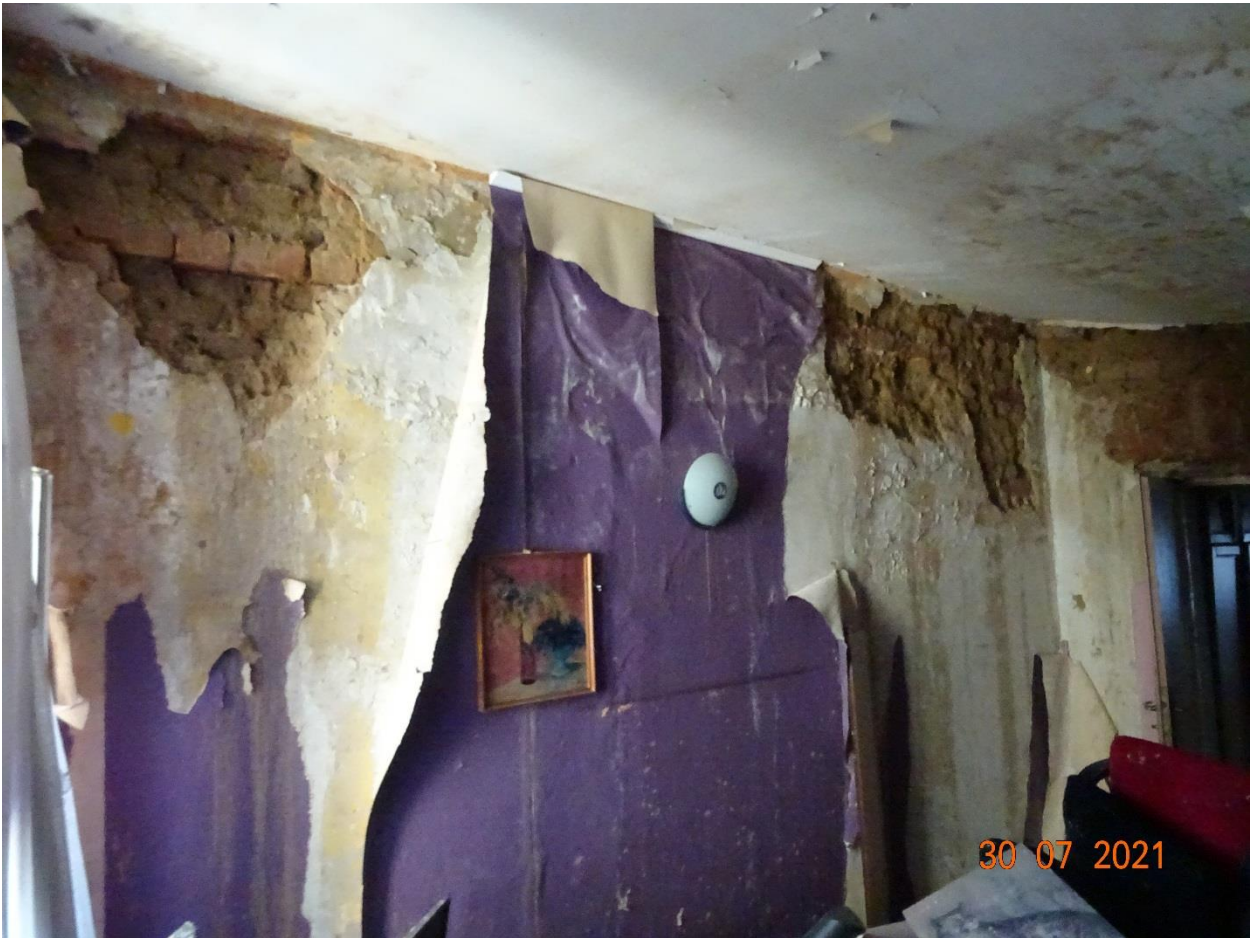
Zdjęcie – widok osi 5, niezależny układ konstrukcji murowej ceglanej od wewnątrz lokalu na piętrze budynku
