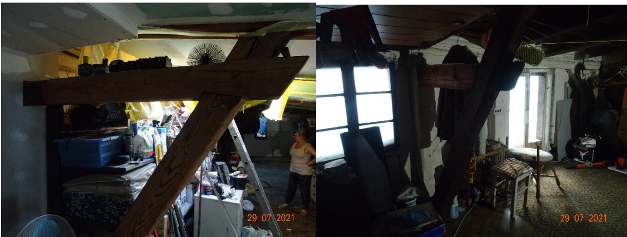
Zdjęcia – widok osi nr „6” od strony poddasza budynku mieszkalnego ul. Mickiewicza 9 z widocznymi elementami konstrukcji nośnej dachu i poddasza z drewnianymi słupami mieczowymi usztywniającymi korowki oraz mury zewnętrzne. Budynek nie posiada autonomicznej ściany zewnętrznej. Oficyna budynku posiada ścianę niezależną.
